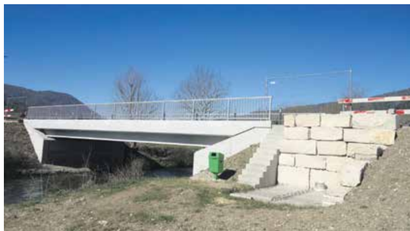
Une barrière définitive sera installée pour éviter tout risque de chute
