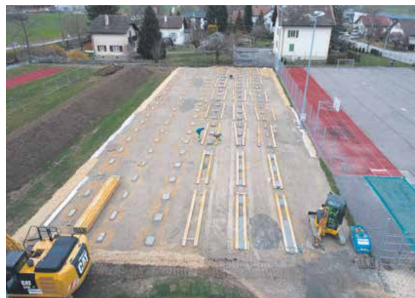
Les travaux de préparation suivent parfaitement le calendrier
