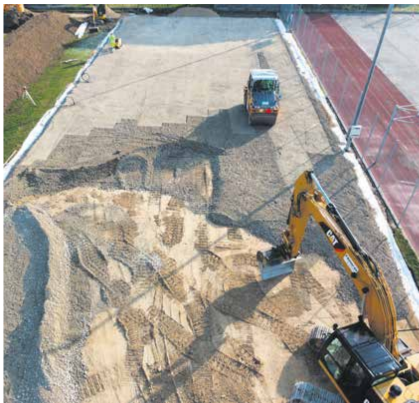
L'installation des conteneurs aura exigé d'importants travaux de terrassement
