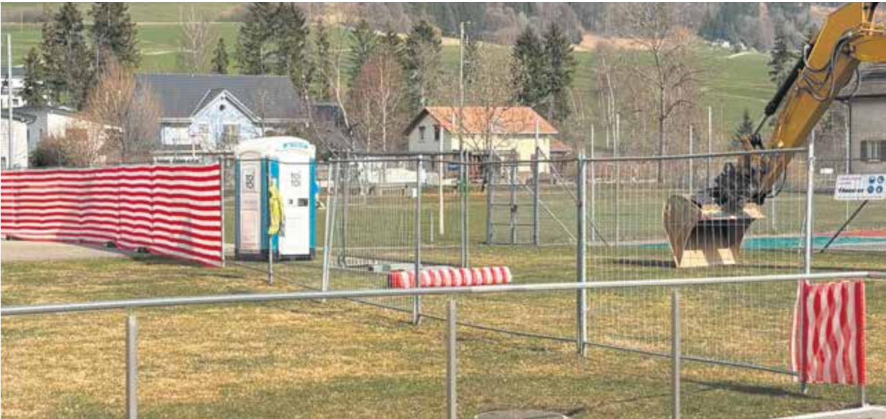
Pour des questions de sécurité, il est impératif de respecter les barrières apposées par les entreprises
