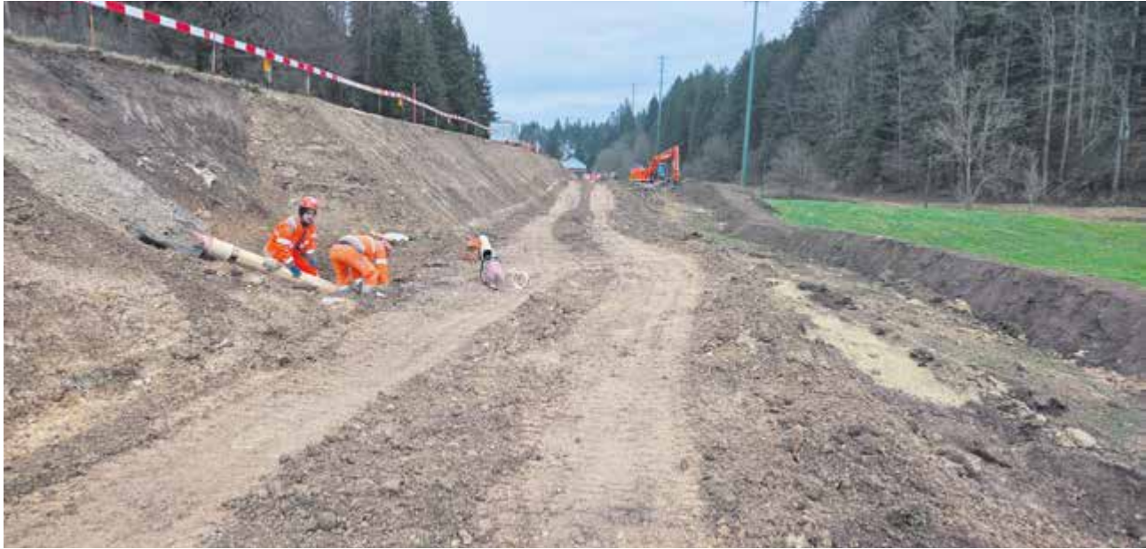
Travaux de construction le long de la Trame
