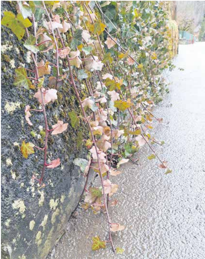
Exemple de plantes qui doivent être coupées à plusieurs centimètres du sol afin de ne pas obstruer l'évacuation et le nettoyage
