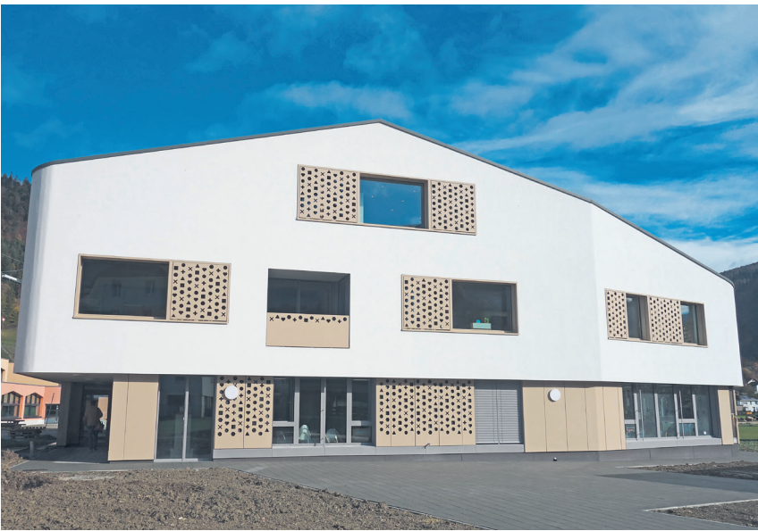
Les derniers travaux se déroulent actuellement aux alentours d'un bâtiment que la population est chaleureusement invitée à venir découvrir dans une quinzaine exactement
