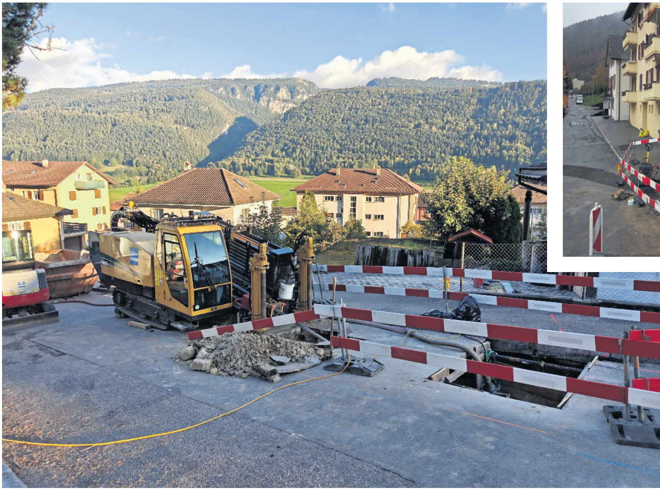
Mise en place de la liaison électrique Champ-Meusel – Paul-Charmillot par forage
