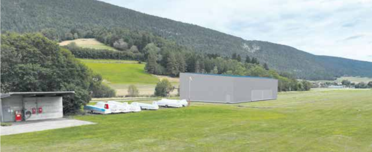
Mise en situation du hangar, vu depuis le sud-ouest
