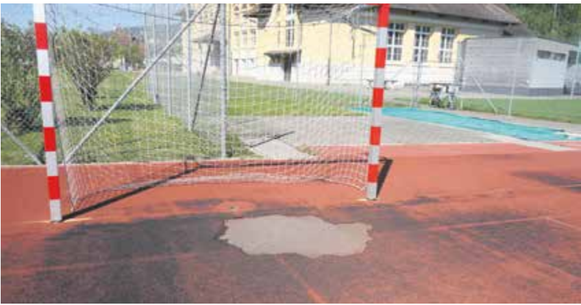
En plusieurs endroits, l'usure du revêtement rend l'utilisation de cette place dangereuse
