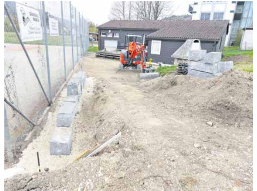
D'ici peu à Cortébert, un magnifique chemin d'accès conduira aux installations du TCC, photo: AM
