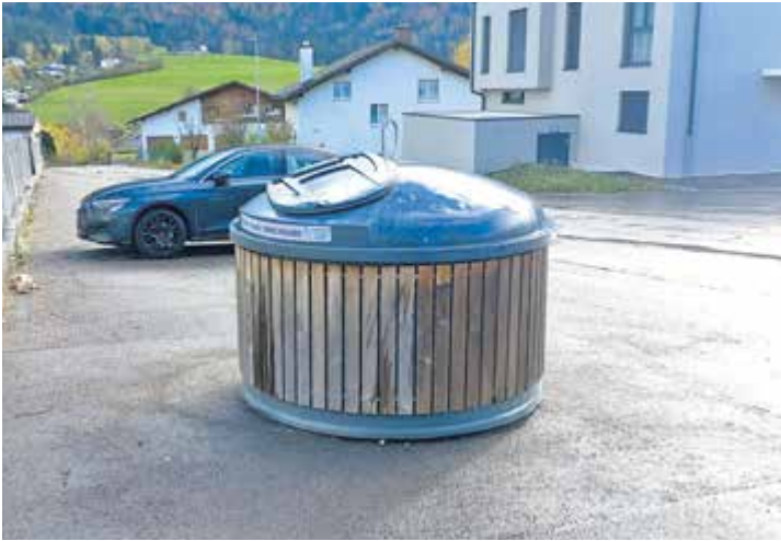
Les conteneurs semi-enterrés bientôt en service
