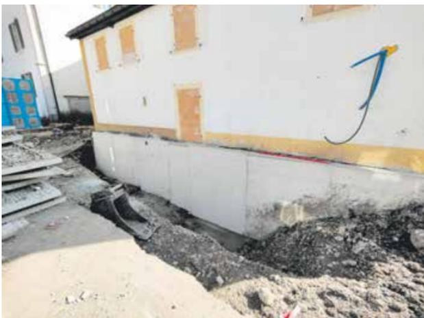
De solides murs de soutènement sont construits pour protéger les bâtiments proches du canal
