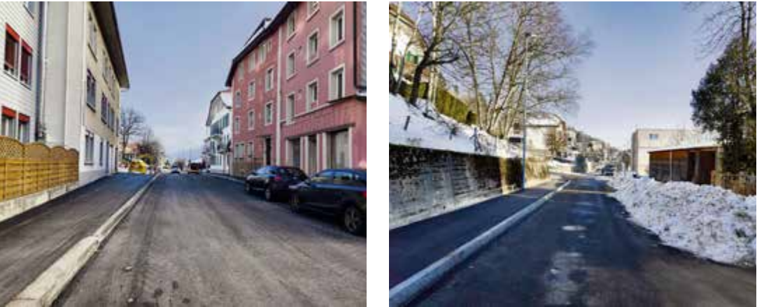
La rue du Vallon et celle de Paul-Charmillot sont à nouveau ouvertes au trafic
