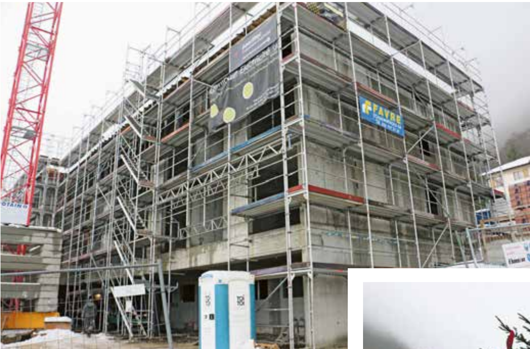
Vue du bâtiment en finition côté sud
