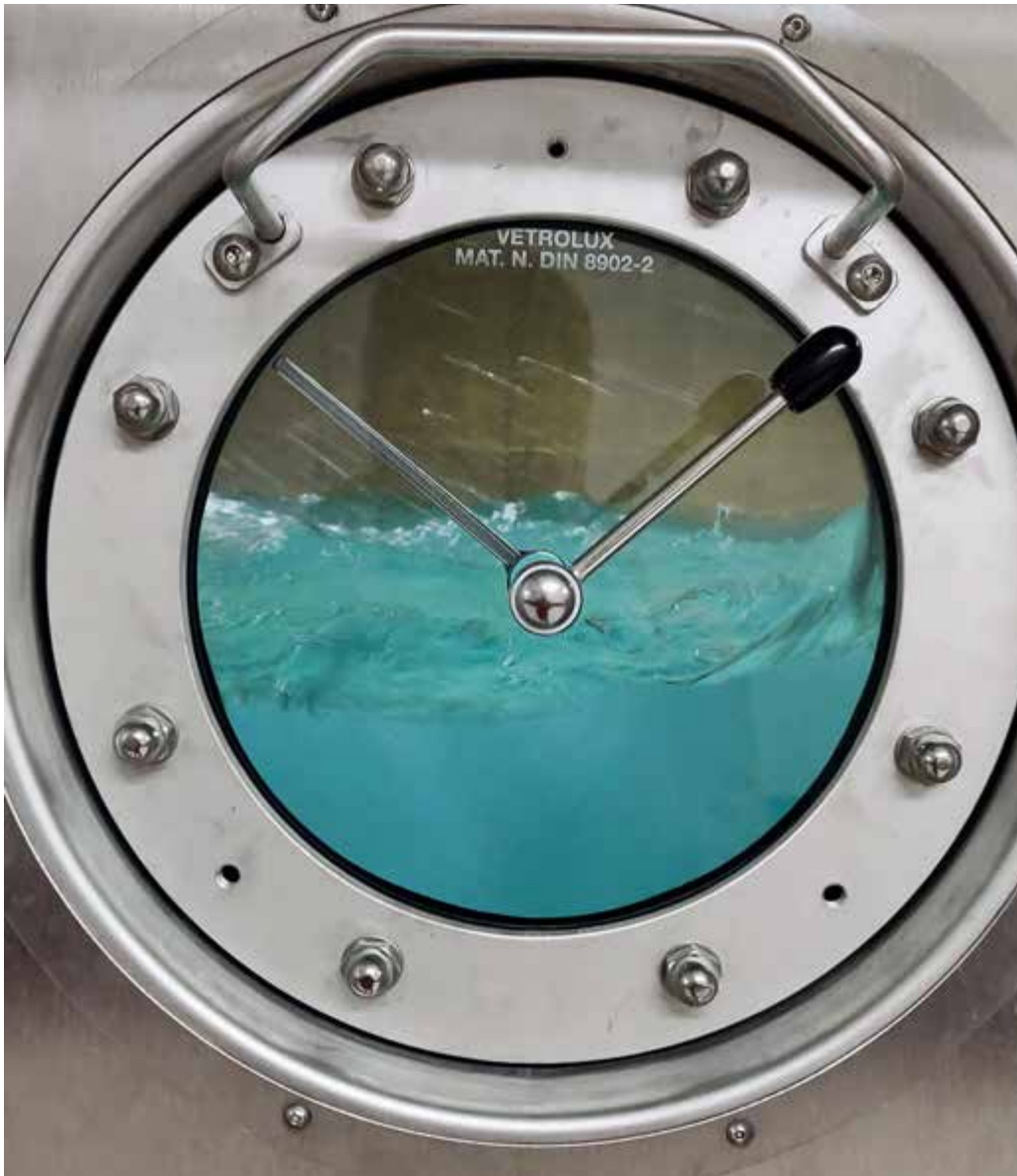
Un hublot de contrôle de la station du puits des Sauges
