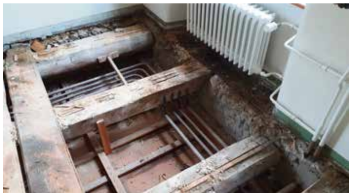
Dans une salle de classe, il a fallu démonter une partie du parquet existant, pour remédier aux défauts découverts sur la pourriture d'époque
