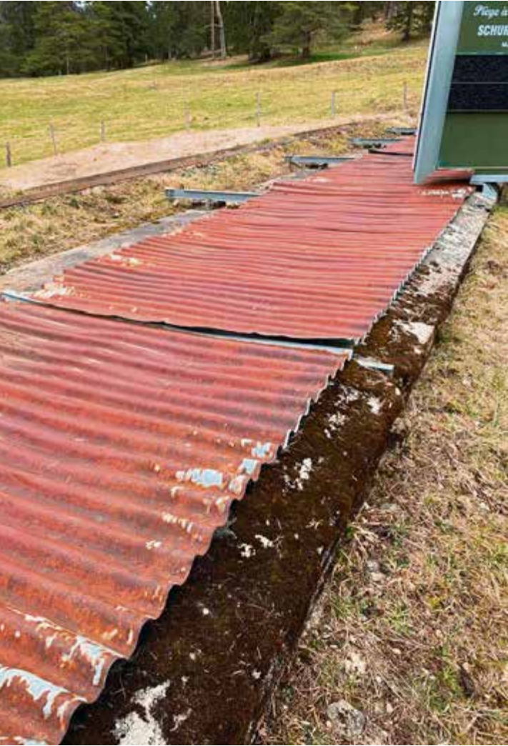
On le constate, ces travaux sont nécessaires
