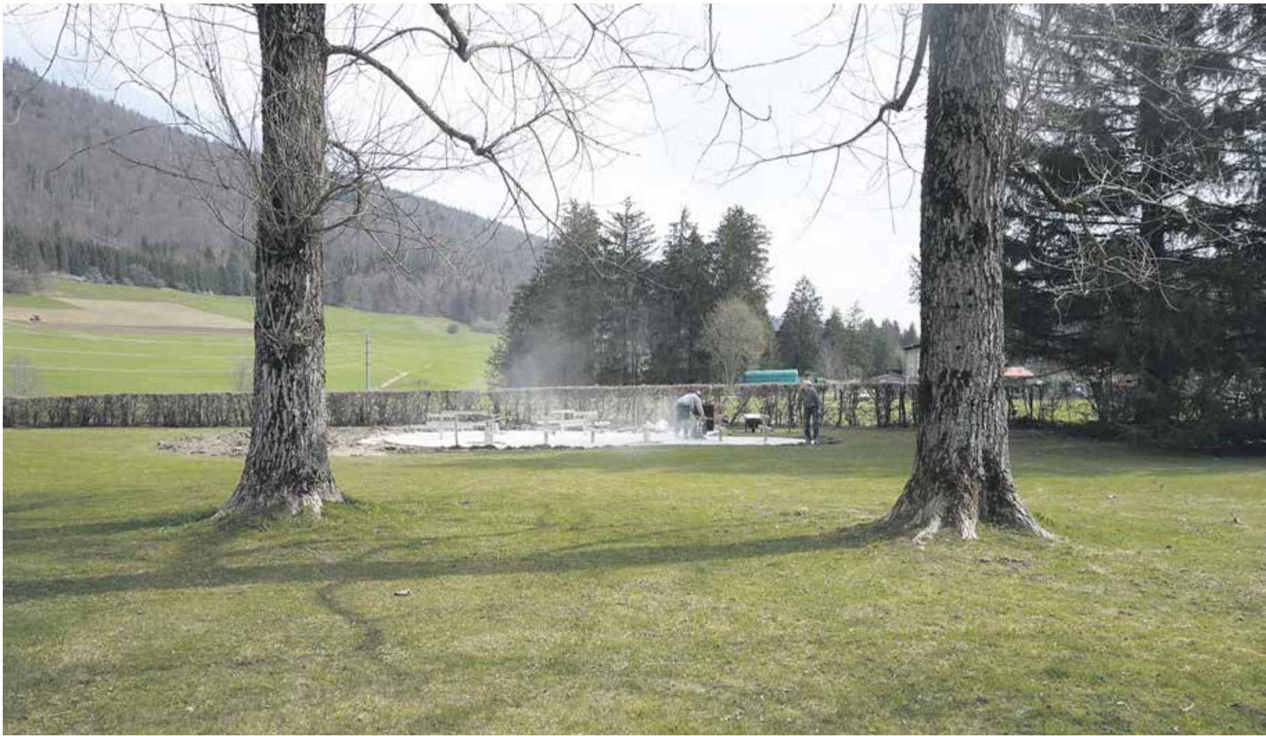
Lundi, on s'activait sur la future place de pique-nique, qui sera accessible dès l'ouverture de la piscine
