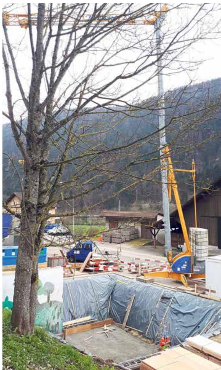
La fosse à copeaux sera tout bientôt bétonnée
