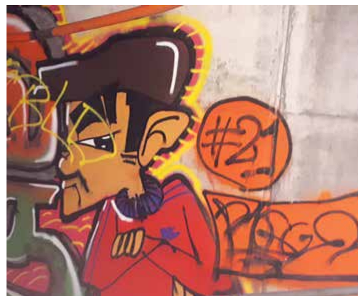
La galerie piétonne menant aux Oeuches n'a pas été épargnée
