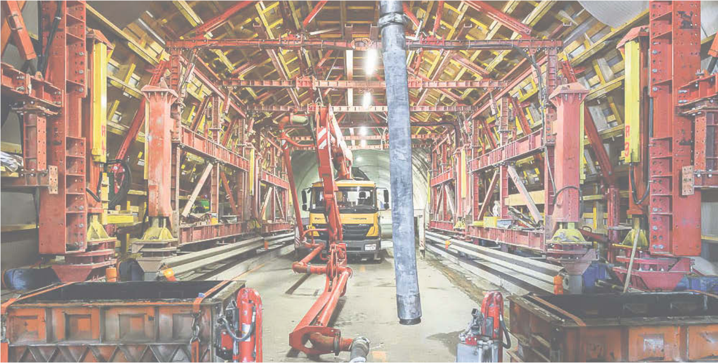
300 mètres cubes de béton fibré ultraperformant seront utilisés sur ce chantier pilote
