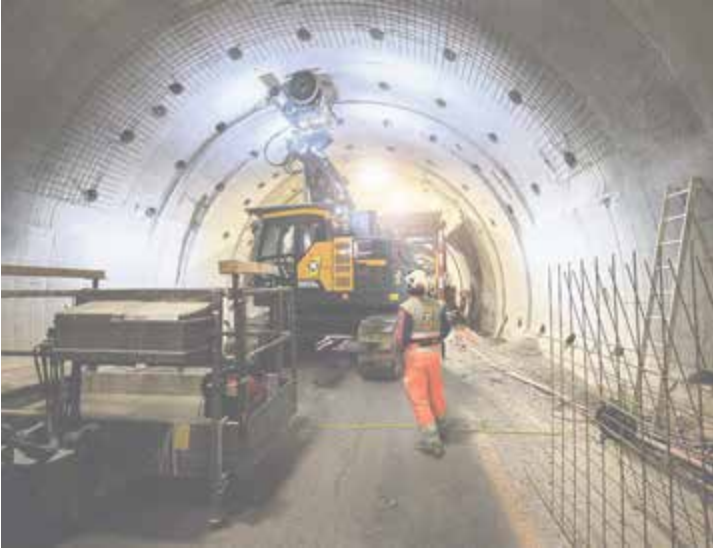
Dans une première phase de travaux, on rabotera la voûte, pour lui enlever quelque 250 mètres cubes de béton
