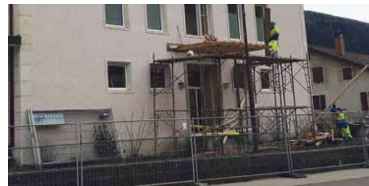
On procède notamment aux travaux préparatoires en vue de l'installation de l'ascenseur
