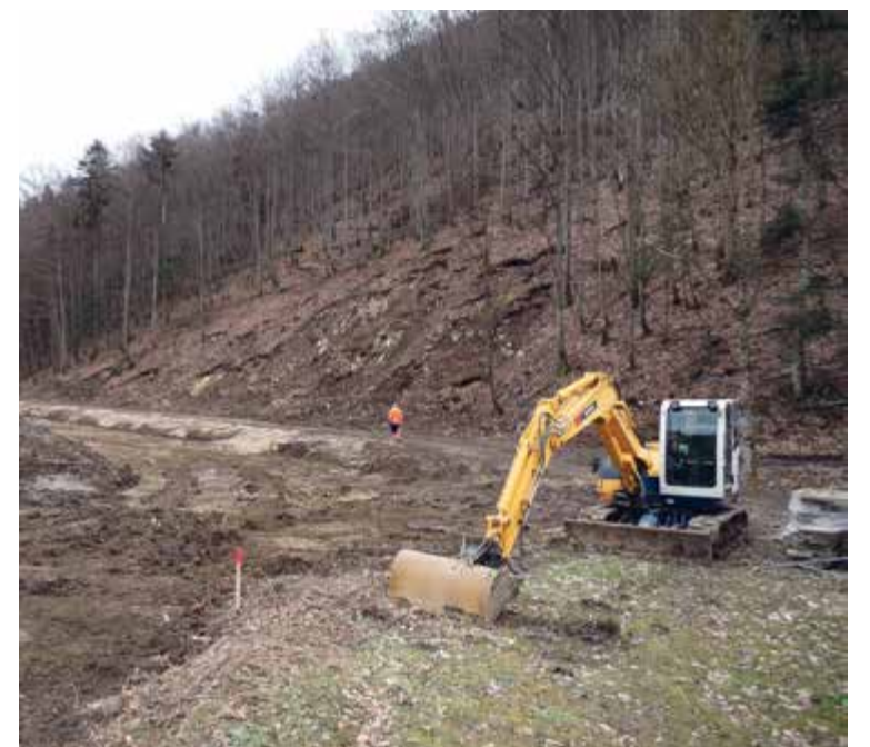
Les travaux ont débuté, en vue de la future galerie de sécurité
