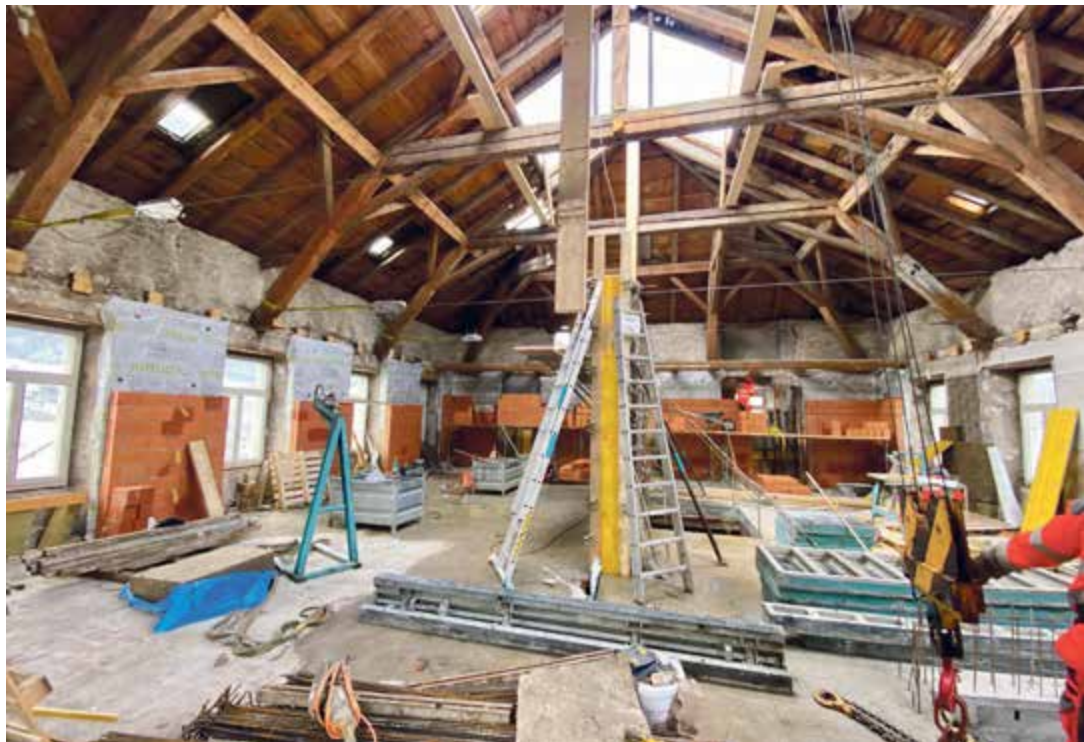
En début de semaine, les préparatifs allaient bon train pour la troisième dalle; on remarquera ici l'ouverture, en toiture, qui permet à la grue d'intervenir à l'intérieur du bâtiment
