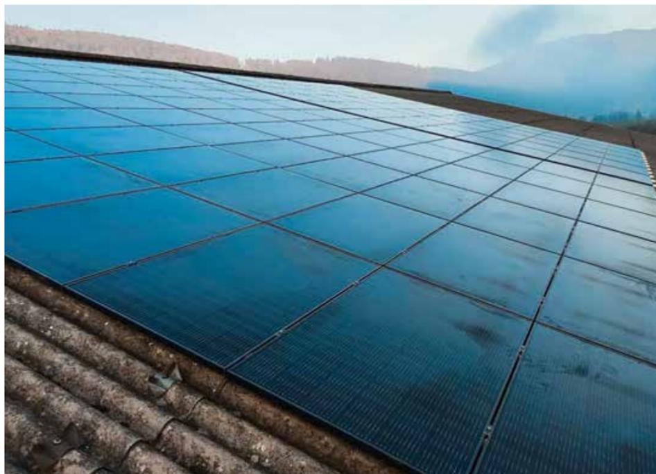
Voici une dizaine de jours que la pose des panneaux solaires a été achevée, sur le toit de la halle La Combe. Ils sont 144 au total et atteindront ensemble une puissance approximative de 45 kWh. Les raccordements sont en cours et la mise en service de cette centrale photovoltaïque est prévue tout prochainement. On soulignera que toutes les entreprises engagées sur ce chantier proviennent de la région très proche : Corgémont, Sonceboz et Cortébert. | cm
