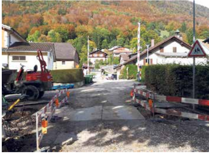
Les travaux avancent, à La Heutte, avec leurs effets provisoires sur la circulation et les tournées de récolte des divers déchets
