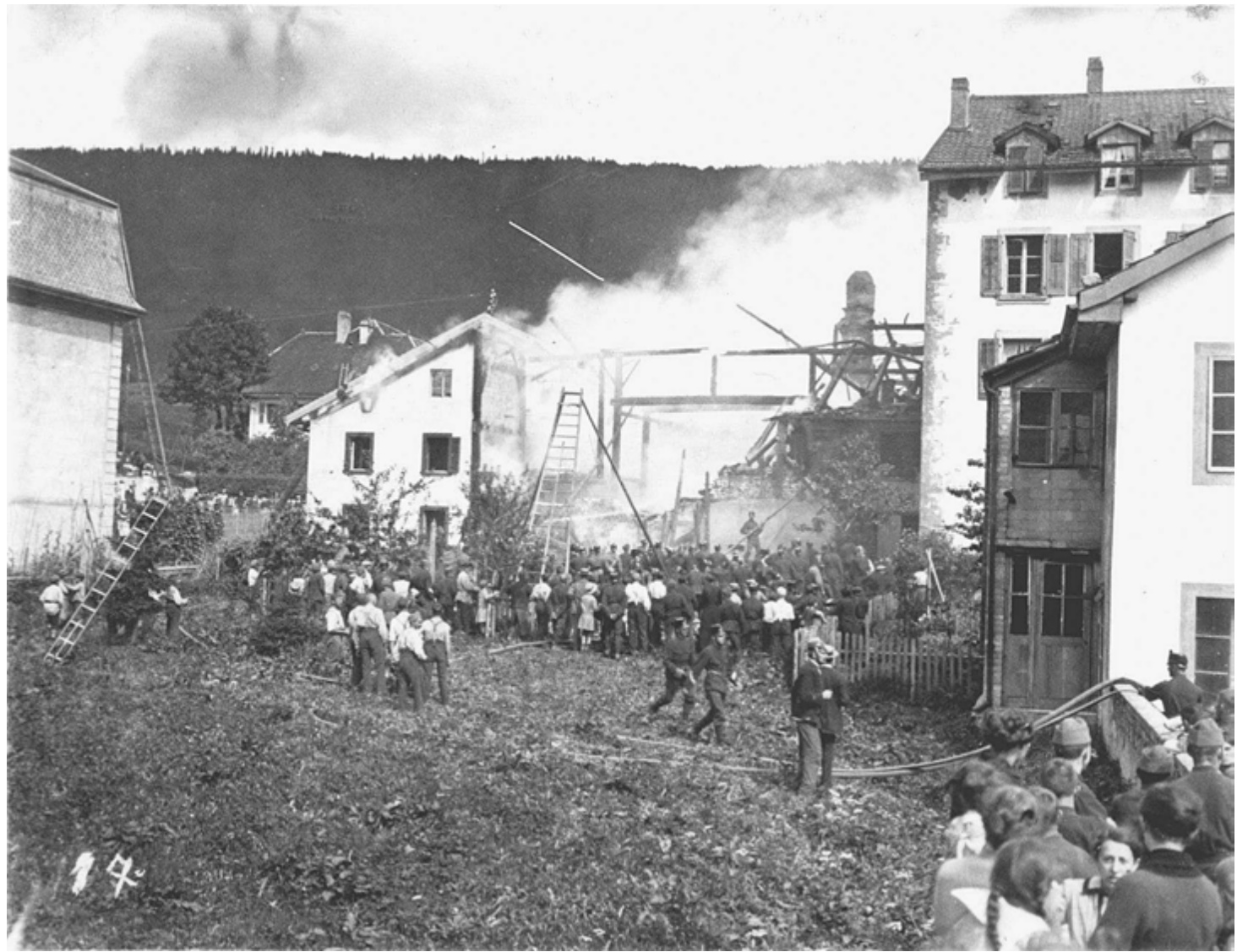
Une vue d'un incendie qui s'est produit en 1920, au 41 de la Grand'Rue; à droite, le bâtiment le plus haut se dresse au 33 de la même rue. Tous les immeubles de cette photo existent encore. (Photo Mémoires d'Ici, Collection Musée de Saint-Imier)
