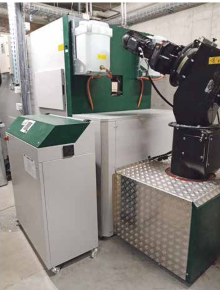
Une vue dans le local de chauffe de la nouvelle installation
