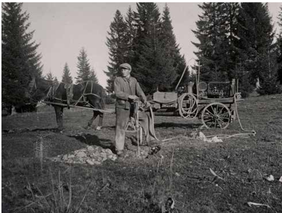
La Chaux-d'Abel, perforatrice pour trous de poteaux, 22 octobre 1926
