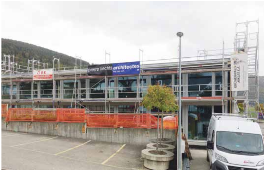
D'ici l'inauguration, dans moins de deux mois, les échafaudages auront disparu de la nouvelle aile, croquée ci-dessus depuis l'ouest
