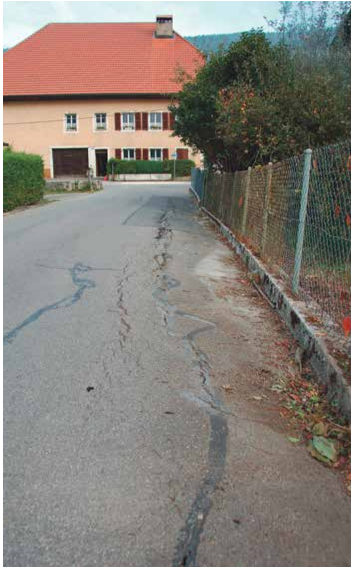
C'est à un tapis très mal en point, notamment, que s'attaquera le prochain chantier de La Châtelaine
