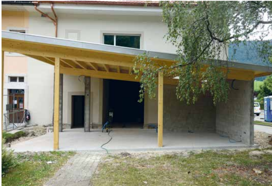
Les travaux de construction du Café communal avancent bien
