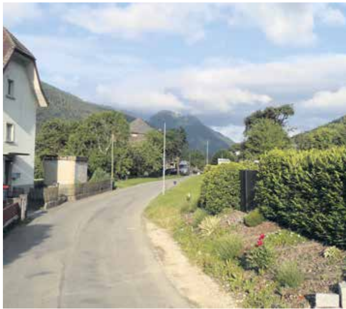
Un crédit est proposé pour refaire le dernier tronçon de la Grand-Rue
