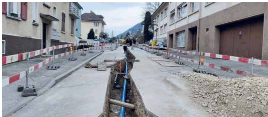
Après la réalisation de la première phase, ici l'état du chantier avant Pâques, les travaux ont repris plus à l'est à la rue de la Fourchaux
