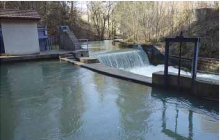
Grâce à la générosité de l'exploitant de cette centrale, Michel Hausmann, des mesures d'améliorations écologiques efficaces sont menées depuis 2007 le long de la Suze
