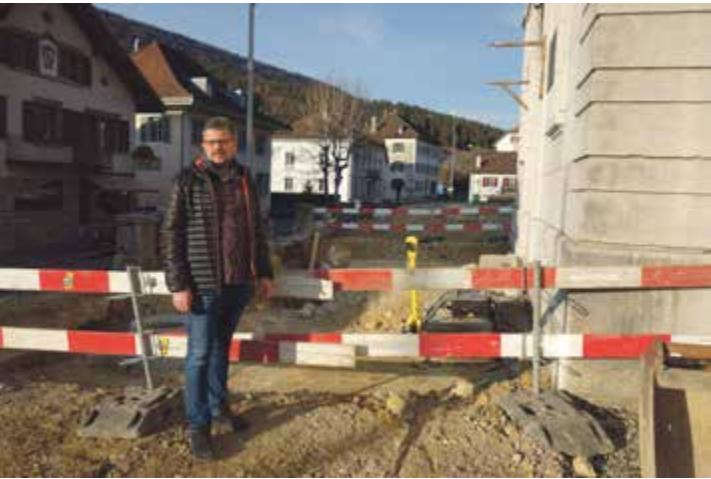
Toutes les conduites extérieures ont été remises à neuf et un coffre optimal construit autour du bâtiment
