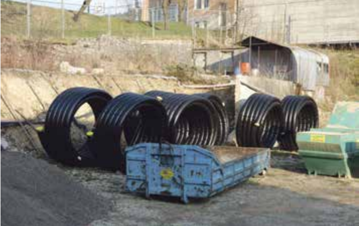
En attente d'installation, les conduites qui relieront le collège au chauffage à distance de Villenergie SA
