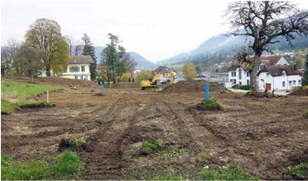
Les travaux ont commencé au début du mois, pour le nouveau home Les Bouleaux
