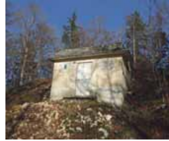
L'ancien réservoir des Fraises, qui date de 1932, aura disparu d'ici une année
