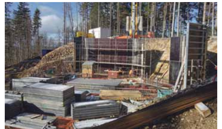
Conséquent, le chantier du nouveau réservoir a pris un peu d'avance sur son calendrier
