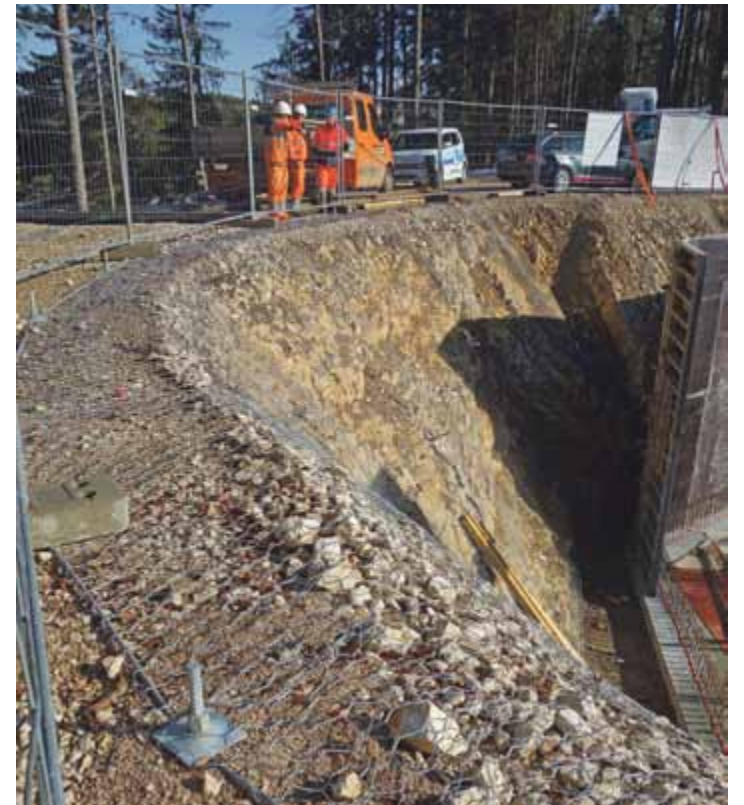
Une surprise qui augmentera la facture: la nécessité de sécuriser l'enceinte de la fouille par un treillis cloué, pour protéger le personnel des éboulements
