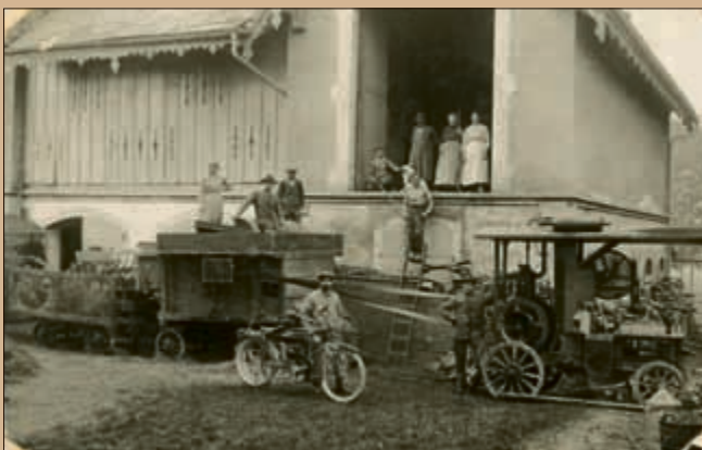
Scène de battage dans les années 1920. Le « moulin à battre » est actionné par un moteur pétrole indépendant. Il appartient à « La Centrale, Machines agricoles S.A. » de Bümpliz, qui se déplace de village en village.
