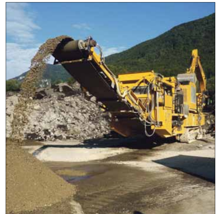
La concasseuse transforme le béton de démolition en granulat réutilisable en construction
