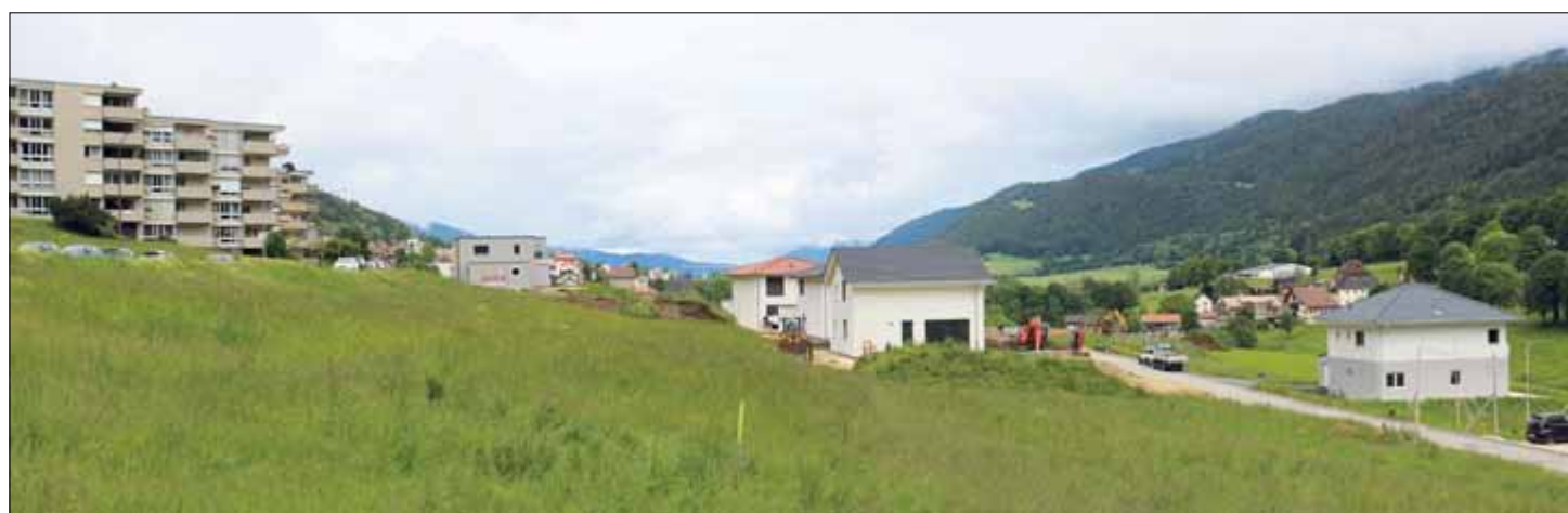
Suivi du parc technologique de Saint-Imier réalisé entre 2017 et 2019 © Parc Chasseral
