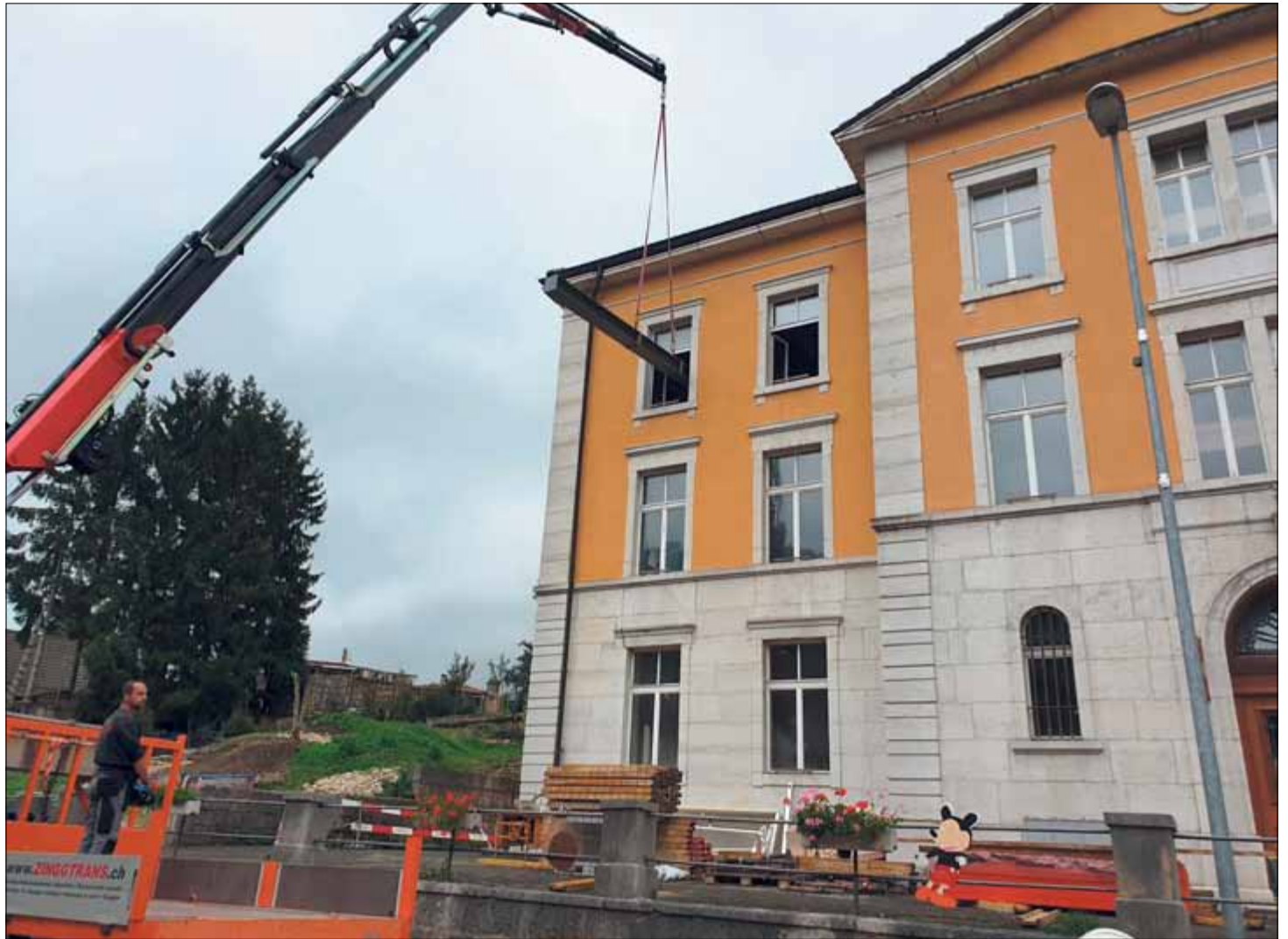
Vendredi dernier en un temps record, les deux poutres métalliques ont trouvé leurs places (photo Frédéric Singer)
