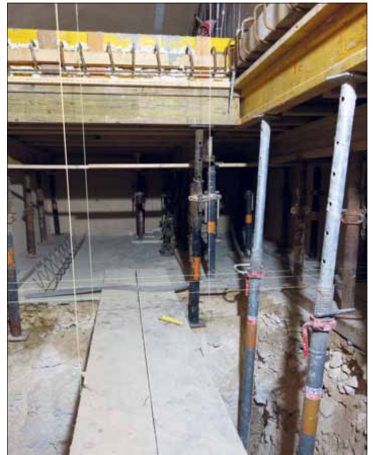
Au sous-sol, pour les fondations du conduit d'ascenseur, le creusage et la pose d'une nouvelle dalle n'ont pas été aisés mais sont aujourd'hui achevés à satisfaction (photo Egger)
