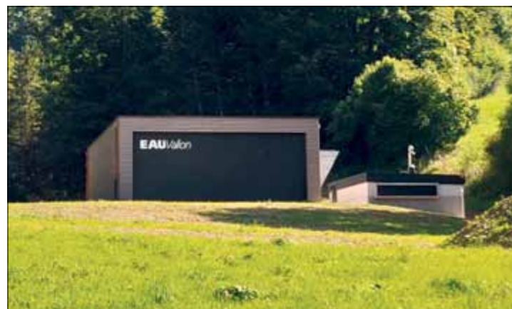
La station de pompage des Sauges offre une ressource qui dépasse largement les besoins quotidiens de Saint-Imier
