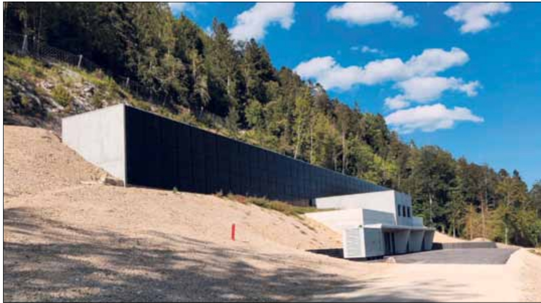
Le réservoir des Philosophes vu de l'extérieur
