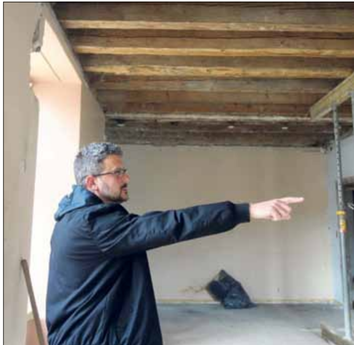
Les travaux avancent vite et bien, souligne Stéphane Lehmann, conseiller municipal en charge de ce projet (photo Egger)
