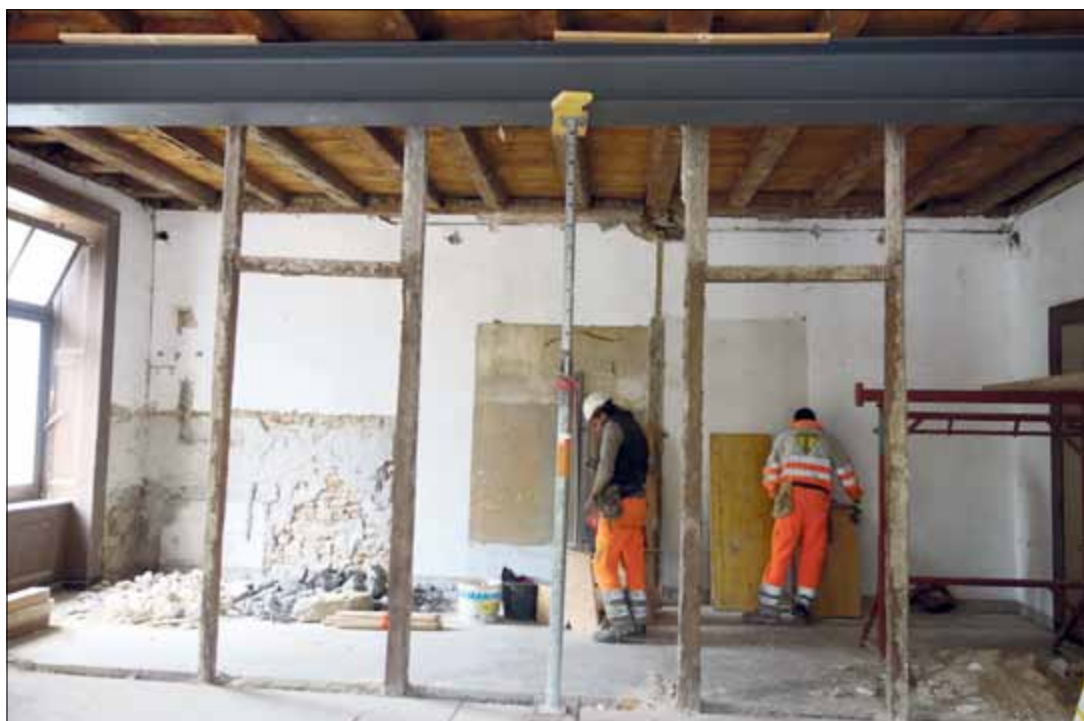
L'une des deux nouvelles poutres métalliques installées pour renforcer la structure du bâtiment (photo Egger)
