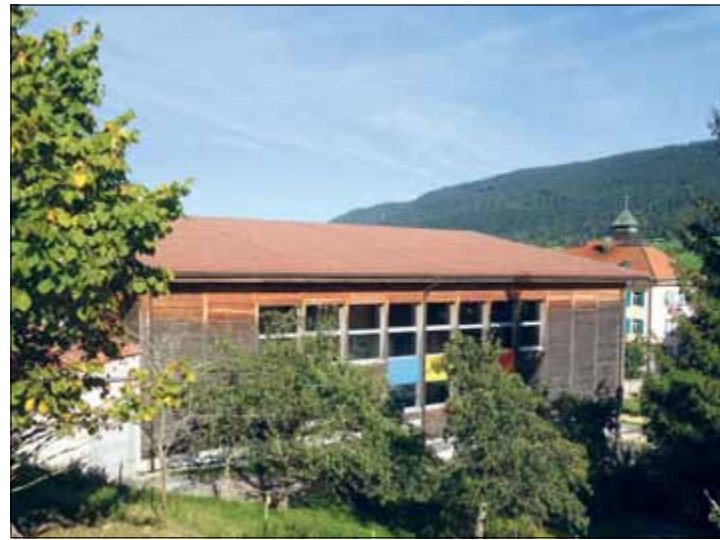
Des panneaux photovoltaïques pourraient trouver place sur ce toit
