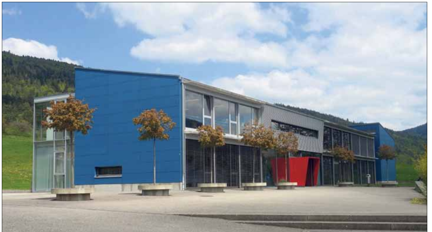
Une deuxième aile sera adjointe à l'Ouest du bâtiment (à gauche sur la photo)
