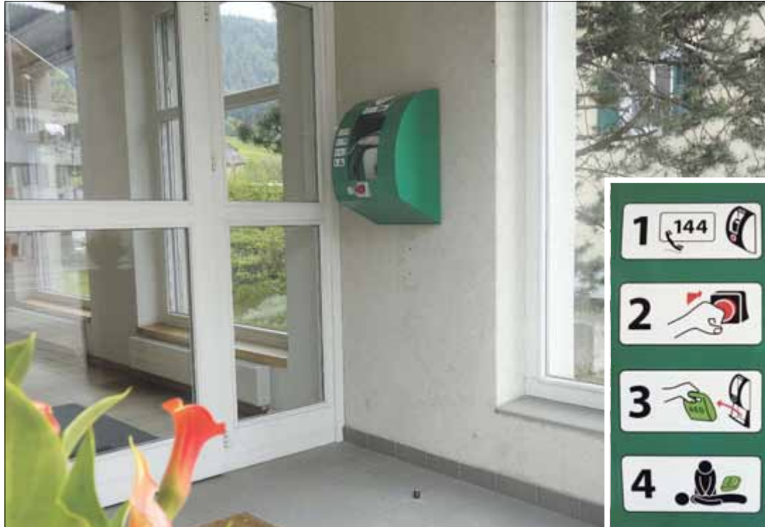
A l'entrée du Centre communal, abrité mais accessible à tous, le nouveau défibrillateur porte sur sa boîte les instructions d'utilisation
