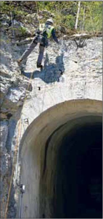
En sus des contrôles techniques, la voie et ses bordures ont été délogées de tout ce qui pourrait se détacher (photo Pierre Pfiffner/funi)
