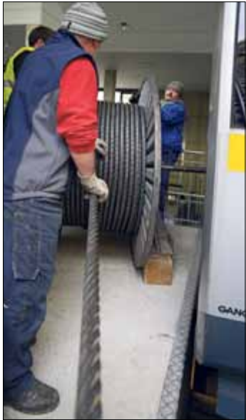
Aucun fil cassé sur le câble (photo Pierre Pfiffner/funi)
