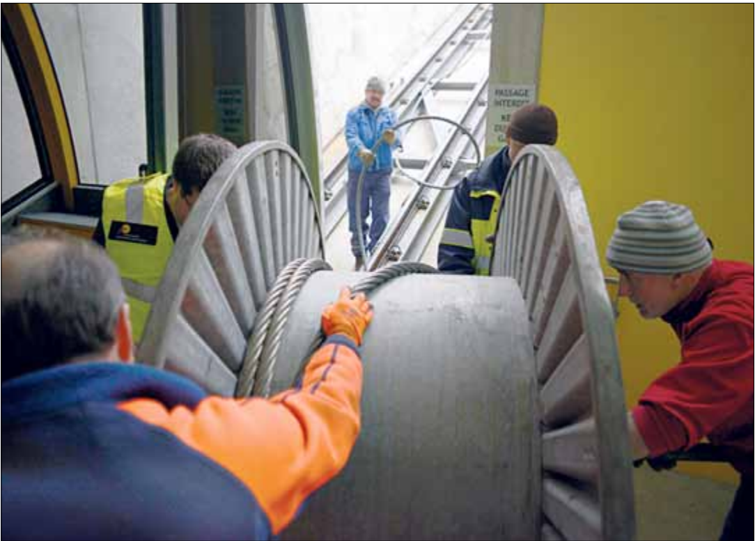
Crucial, le contrôle du câble de traction (photo Pierre Pfiffner/funi)
