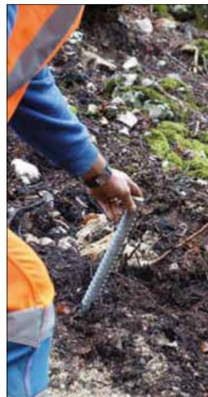
La semaine dernière, on a procédé aux forages de test pour déterminer la profondeur et la distance nécessaires des ancrages.
