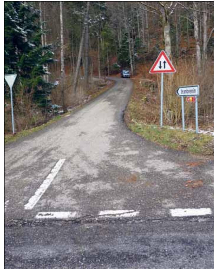
La portion de route qui devrait être « dégoudronnée »
