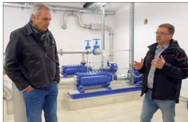
L'imérien Patrick Adatte (à droite) et le Franc-Montagnard Pierre-Alain Barthe, deux spécialistes qui suivent le chantier quasi quotidiennement
