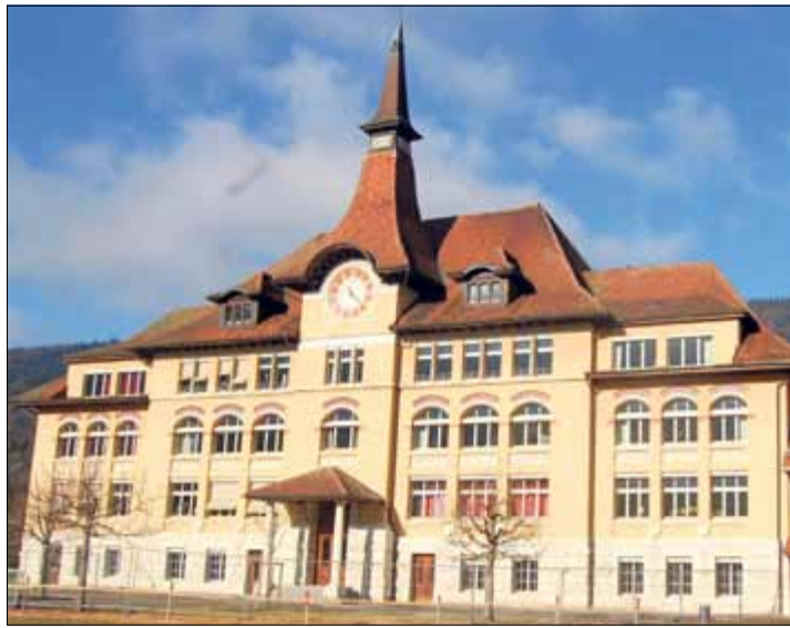
Désormais au complet, la commission ad hoc va plancher sur la rénovation du collège
