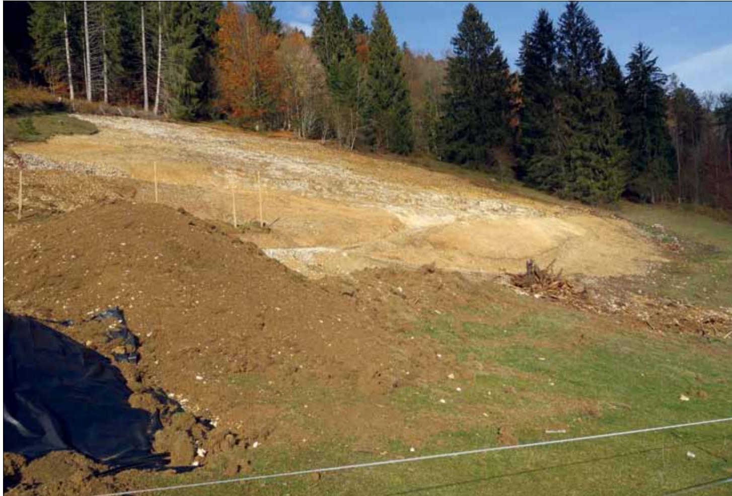
C'est ici exactement que commenceront l'an prochain les travaux de construction du nouveau réservoir intercommunal
