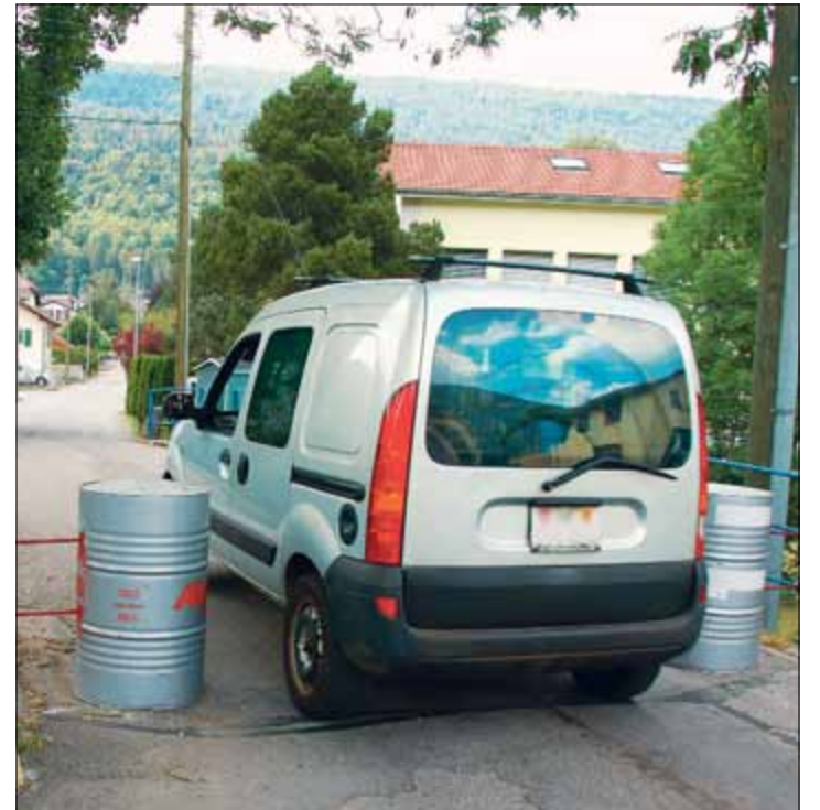
Le rétrécissement installé provisoirement sur le pont des Lilas
